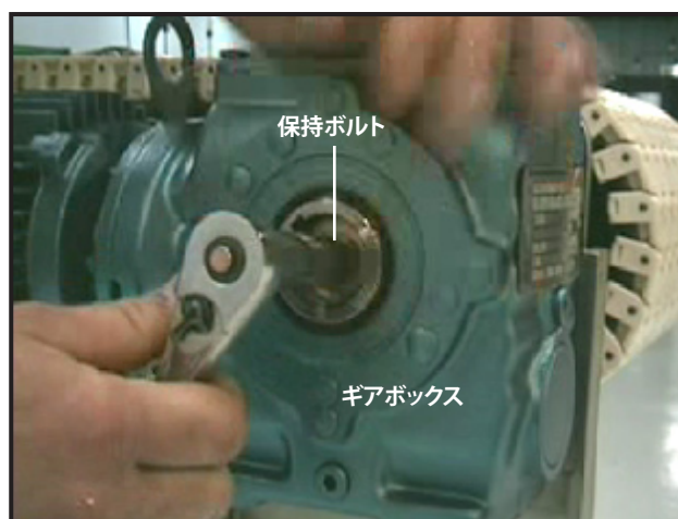
図38: 保持ボルトを挿入して締め付け
