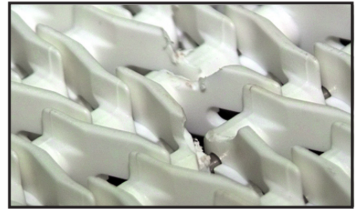
リンクが壊れていないかどうか、チェーンを点検します。
