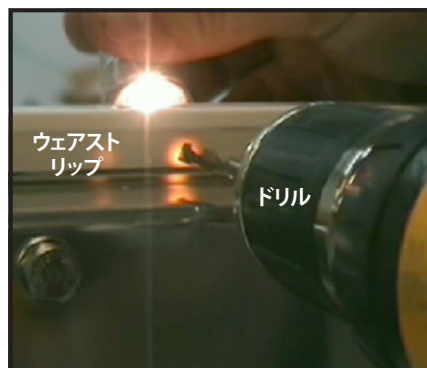
図15:ライトを使用して穴を確認。ウェアストリップにドリルで穴を開ける
